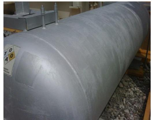
Con este reporte queda comprobado físicamente que **después de 1 año 8 meses**, Nuestras cajas de circuitos y tanques de Nitrógeno, se encuentran sin OXIDACION, CORROSION, NI ATAQUES DEL MEDIO AMBIENTE U OTROS.
